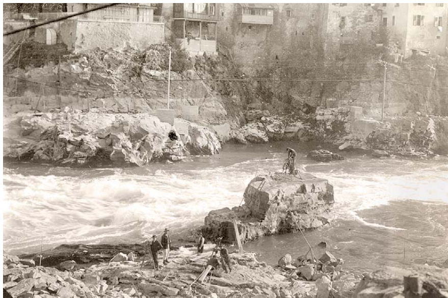
Vorbereitung für die Sprengung der Roten Fluh am 28.10.1910, SLK 1043 Archiv MS
