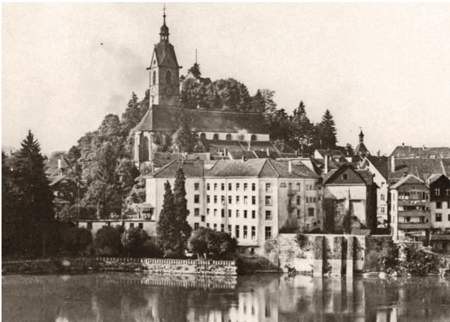
Die Fotografien zeigen das Hotel Solbad vor dem Abbruch der „Münze“ (oben) und nach ihrem Abbruch (unten). (Archiv Museum Schiff)
